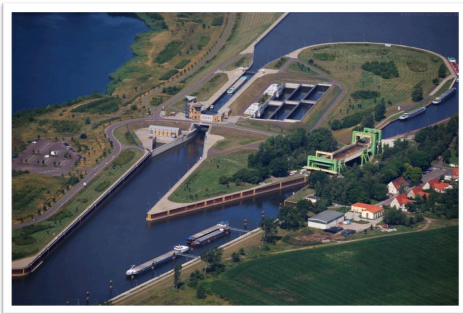
*Das grün-gelbe Schiffshebewerk auf der rechten Seite und parallel davon die moderne Schleuse für Frachtschiffe.*
